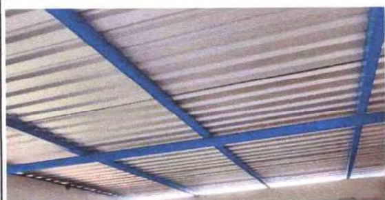
FOTO 1: SUSTITUCION DE LAMINA TROQUELADA ALUZINC CALIBRE 26 MODULO DE COCINA
