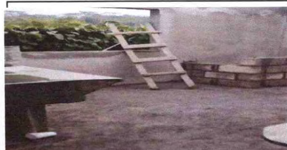
FOTO 10: SUSTITUCION DE TUBERIA PVC LINEA PRINCIPAL AGUAS NEGRAS MODULO DE COCINA
