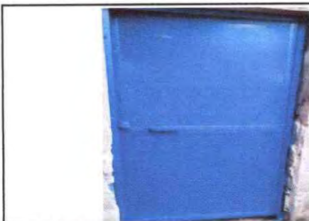
FOTO 3: FABRICACION E INSTALACION DE PUERTAS DE METAL EN MODULO MODULO DE COCINA
