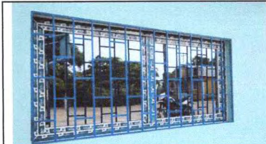
FOTO 4: SUSTITUCION DE VENTANA DE MADERA POR METAL MAS VIDRIO MODULO DE COCINA
