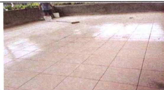
FOTO 16: SUSTITUCION DE PISO CEMENTO LIQUIDO POR PISO CERAMICO EN MODULO DE AULA
