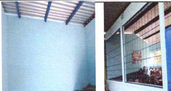
FOTO 8: PINTURA EN MUROS EXTERIORES E INTERIORES EN MODULO DE AULAS Y COCINA
