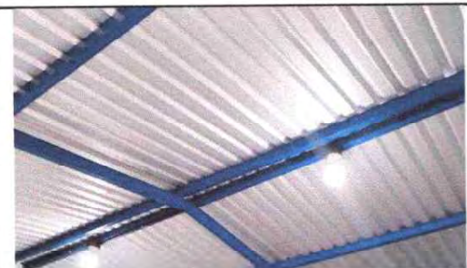
FOTO 11: SUSTITUCION DE FOCOS AHORRADORES SUSTITUCION DE PLAFONERAS Y SUSTITUCION DE DUCTO ELECTRICO + ACCESORIOS MODULO DE COCINA
