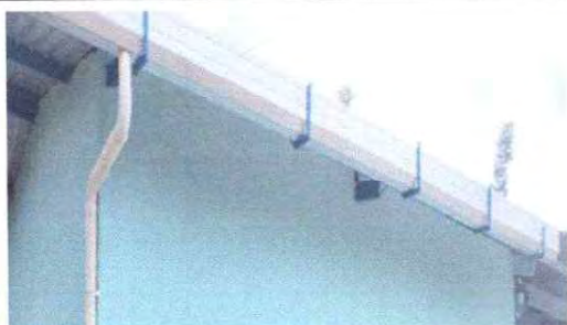
FOTO 7: SUSTITUCION DE CANAL DE METAL Y SUSTITUCION DE BAJADA DE AGUA PLUVIAL DE METAL POR TUBO PVC 3 MODULO DE COCINA
