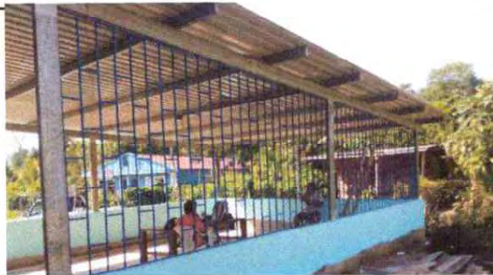
FOTO 15: FABRICACION E INSTALACION DE VENTANA-BALCON DE METAL EN MDULO DE AULA
